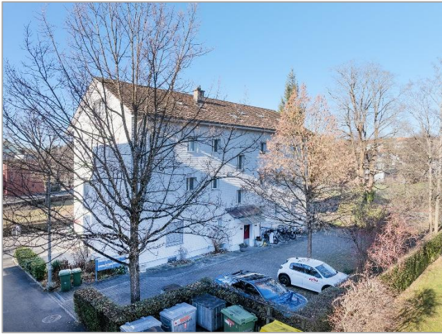
Ostansicht mit Parkplätzen
